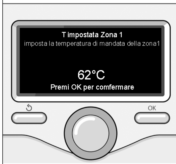
Modifica temperatura acqua calda riscaldamento
