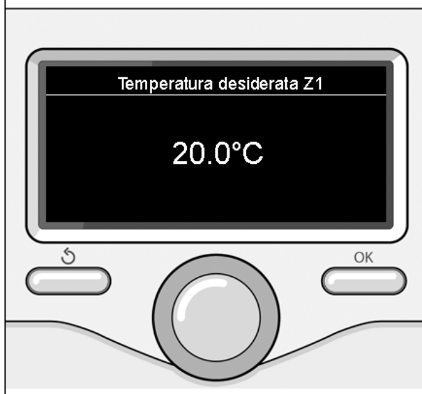
Modifica temperatura ambiente
